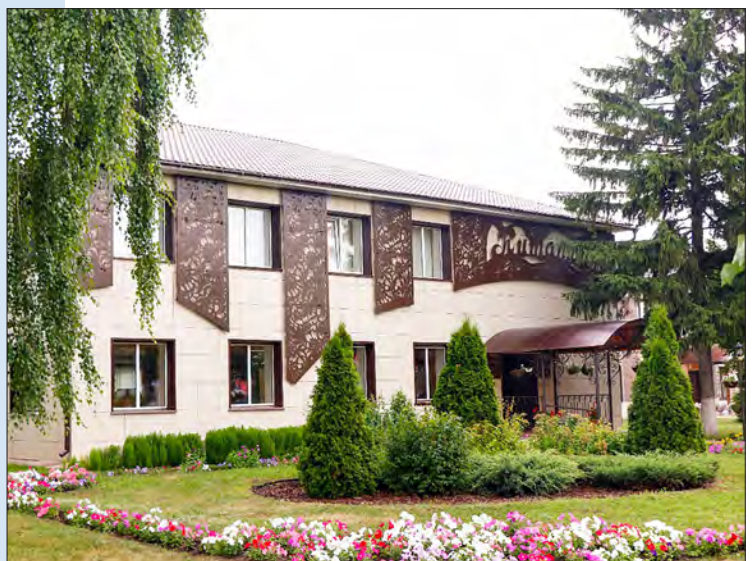
Район Үзәк китапханәсе бинасы Фасад Центральной библиотеки района
